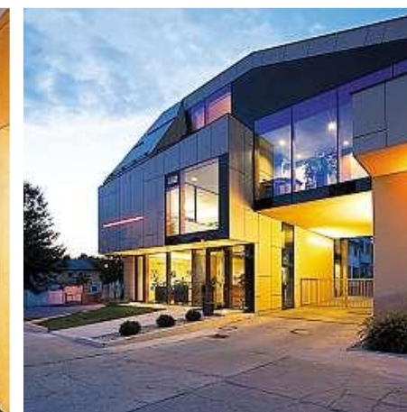
Das gesamte Gebäude wird über eine Wasser- bzw. eine Wasser-Wärmepumpe beheizt. Dafür wird das Grundwasser verwendet
